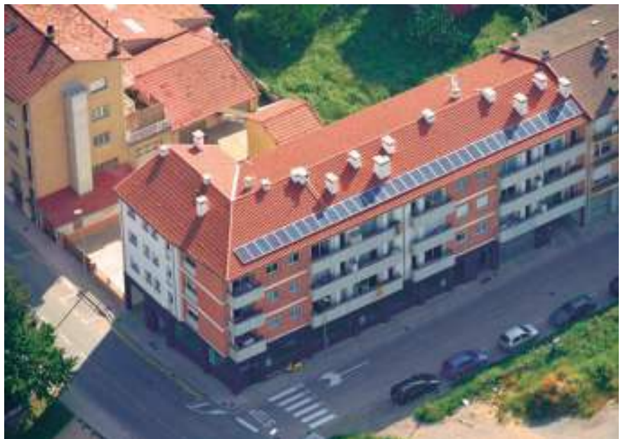
▲ EspaiZero: oficines de la planta baixa i plaques fotovoltaïques a la teulada de l'edifici
