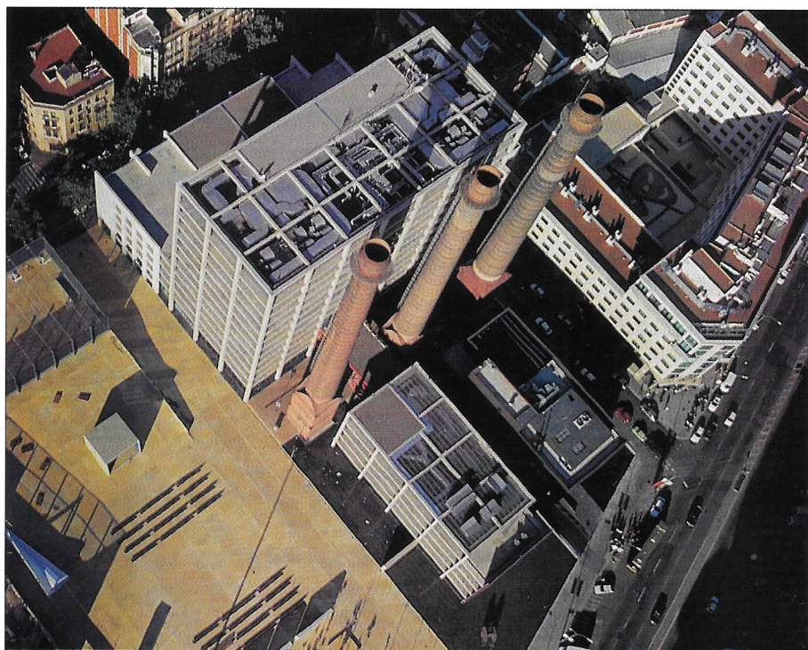
Imagen aérea de las torres de la eléctrica Fecsa, empresa sobre la que Endesa —presidida por Feliciano Fuster (en la página siguiente)— ha realizado una opa
