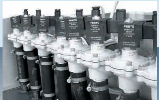
La válvula de impulsos VZWE se monta entre el acumulador de aire comprimido y las válvulas integradas en las tuberías, con el fin de retirar el polvo que se deposita sobre los filtros, generando con ese fin vibraciones con aire comprimido.
