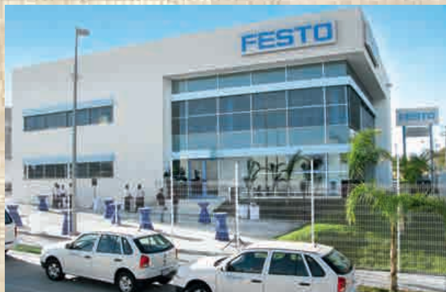
El moderno edificio de Festo en Guadalajara, en la parte occidental de México.
