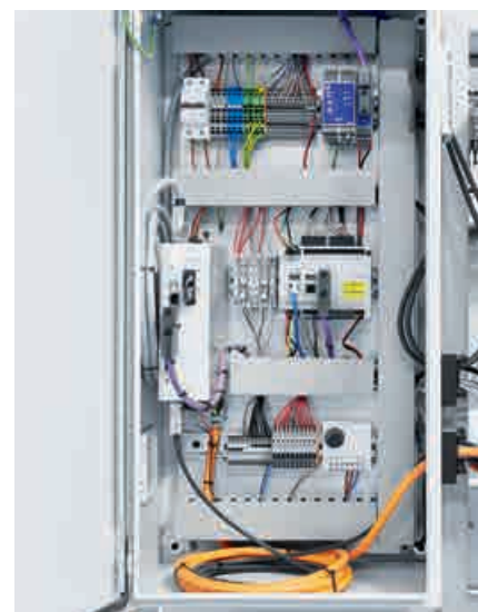
Todo bajo control en el kit de prensado YJKP: controlador CECC-X y controlador de motor CMMP, inclusive software de aplicación.
