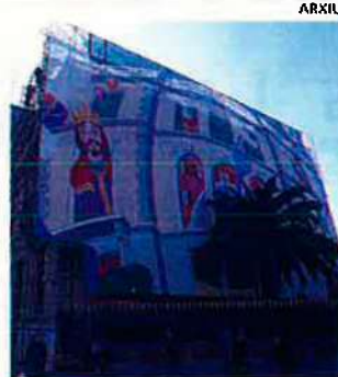
Façana del Palau Robert de Barcelona, on hi ha el centre.
