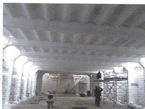
Pintura intumescent Certificat de resistència al foc de 30 a 90 minuts
