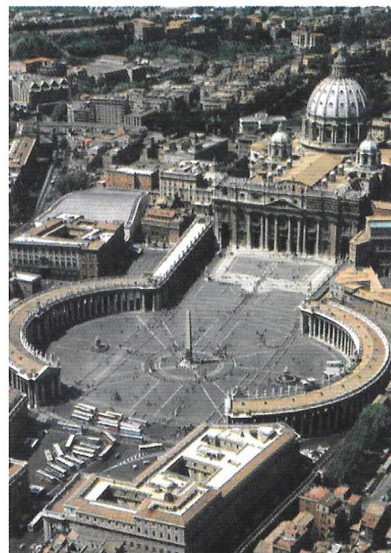
El Vaticà instal·larà panells fotovoltaics en algunes de les seves instal·lacions com ara l'auditori Pau VI
