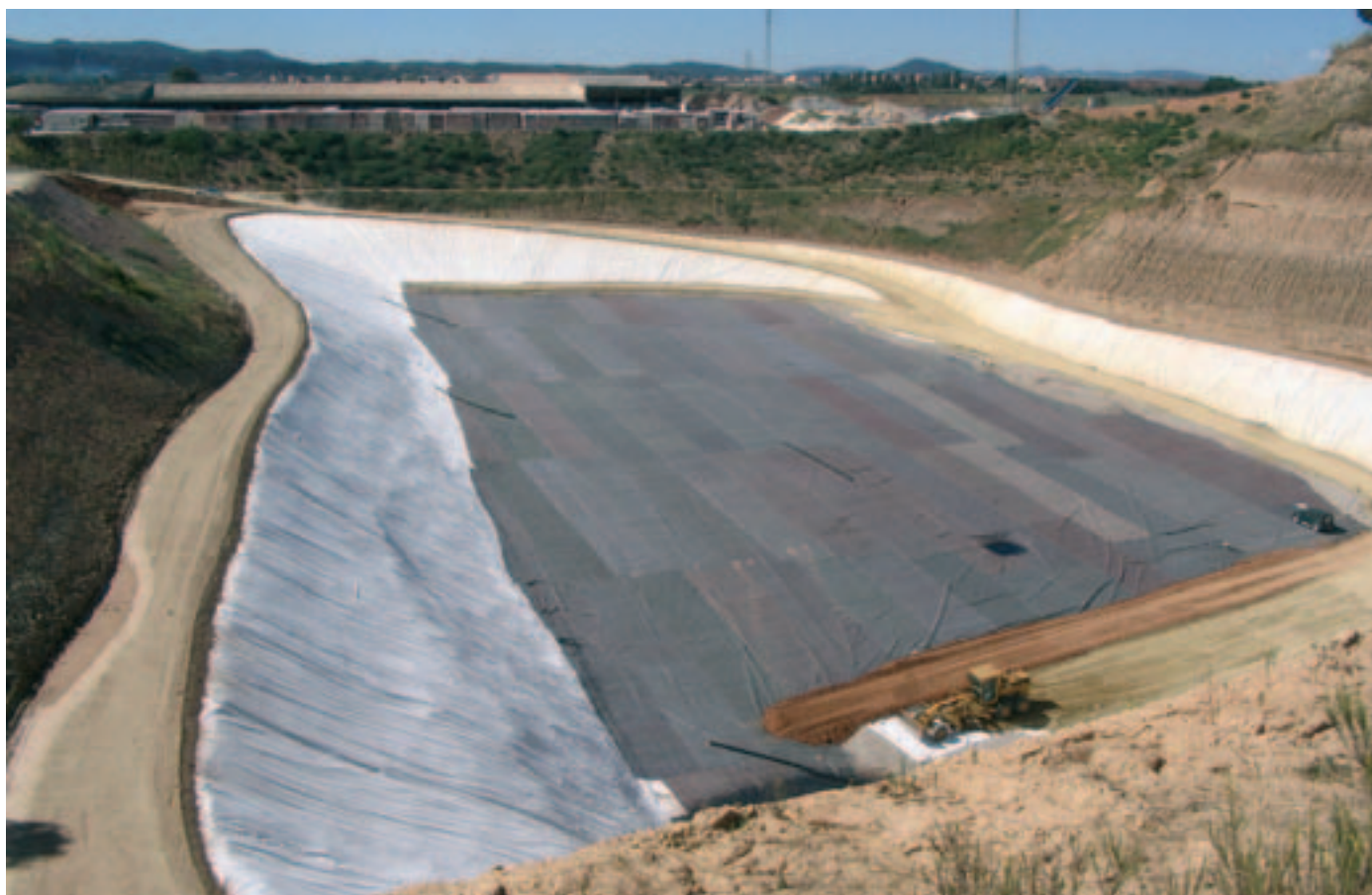
Treballs d'adequació de l'argilera Elena de Cerdanyola del Vallès per a ser restaurada amb bales provinents de l'Ecoparc 2 de Montcada i Reixac
