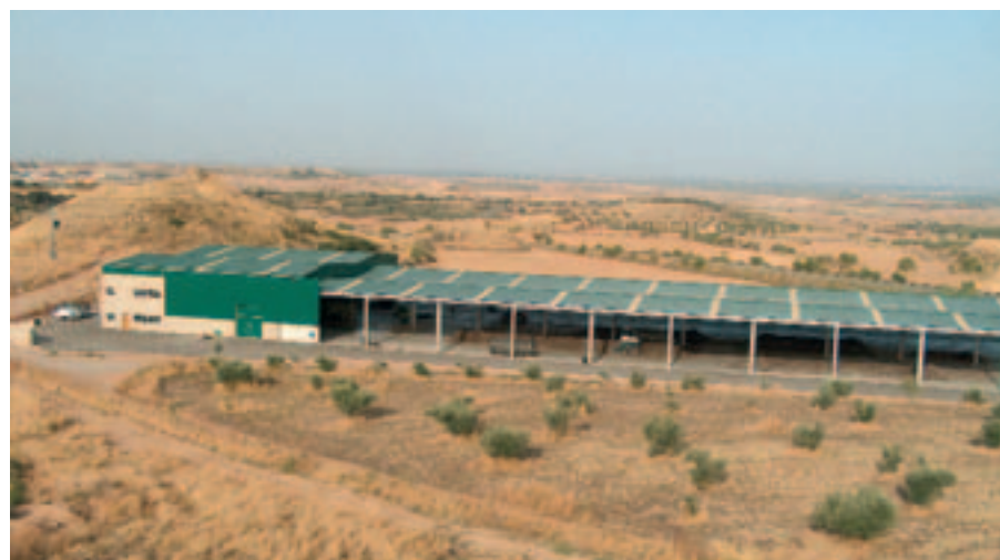
Planta de compostatge de Tàrraga
