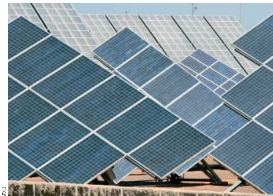
Les instal·lacions fotovoltaiques fixes es componen de mòduls, caixes de connexions, inversors i transformadors
