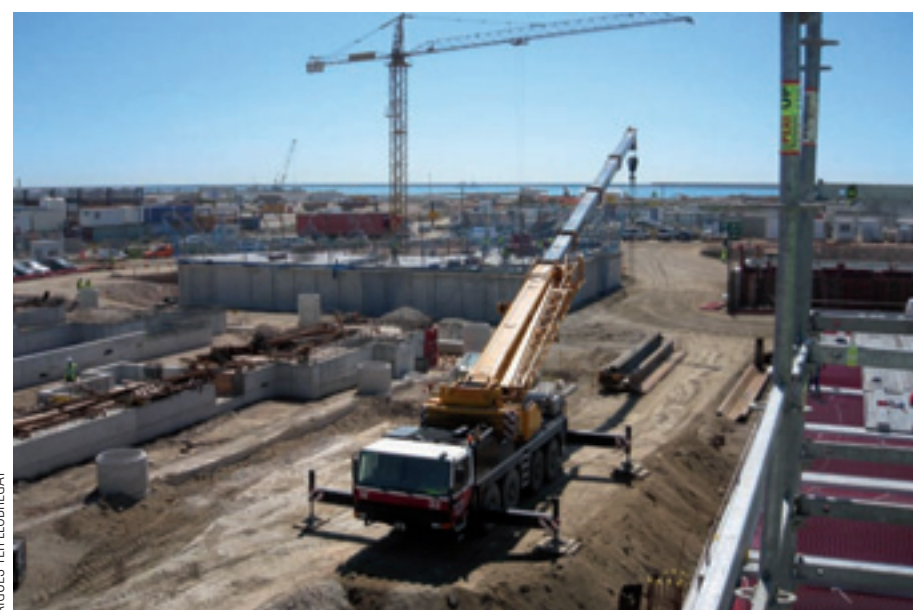
La dessaladora del Llobregat es troba en ple procés de construcció i es preveu que estigui a punt per a l'any 2009
