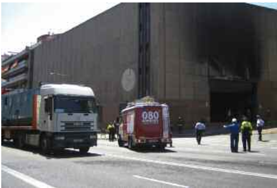
Un any després del tall elèctric REE ha finalitzat les obres de la subestació de Maragall
