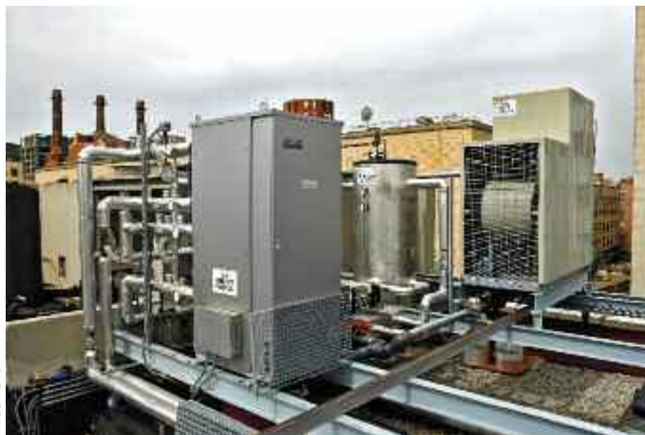
Vista de la màquina d'absorció, acumulació de fred, torre de refrigeració i la primera fila de captadors solars
