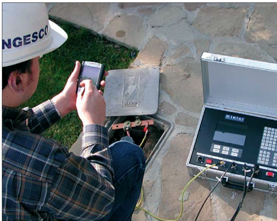
Imatge 7. És molt important que tot el muntatge del parallamps es trobi sempre en perfectes condicions
