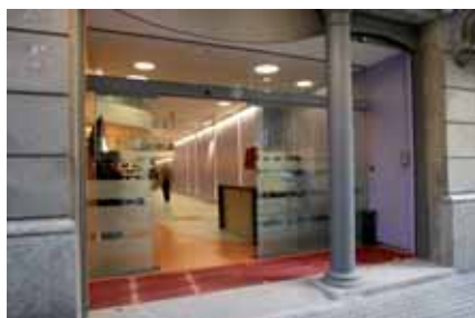
Aspecte exterior de l'accés al Tecnoespai
