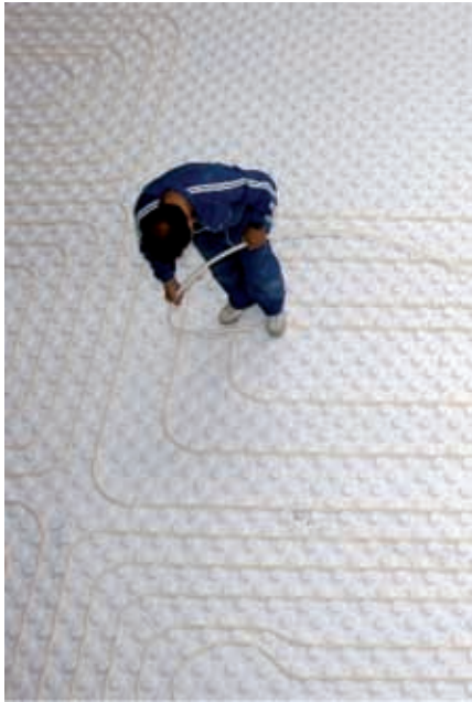
Instal·lació de sòl radiant
