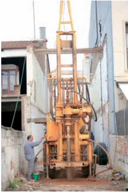
Instal·lació de sonda geotèrmica
