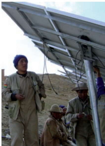
Instal·lació de sistemes d'electrificació amb energia solar
