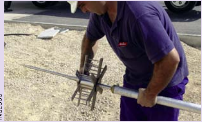
Un operari treballa en la instal·lació d'un parallamps
