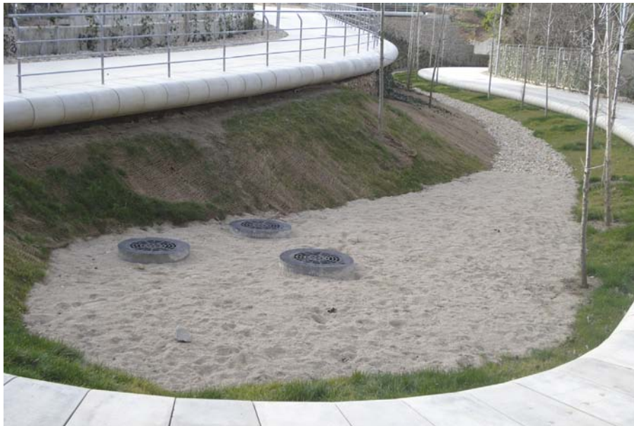
Cel·la de drenatge o tedus situada al parc barceloní de Joan Raventós, a l'antic Torrent de les Monges
