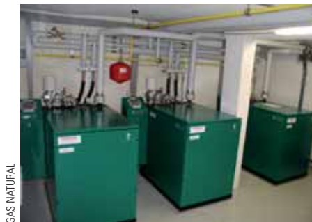
Equips de microgeneració
