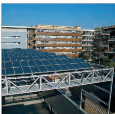
Plaques fotovoltaiques instal·lades a la teulada d'un edifici de la Universitat de Barcelona.
