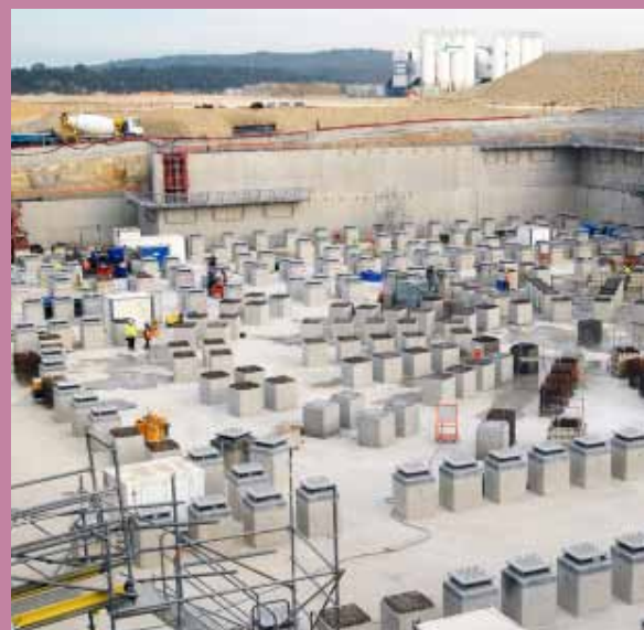
Estructura antisísmica de la plataforma de l'edifici Tokamak que construirà un consorci amb participació de l'empresa espanyola Ferrovia.
