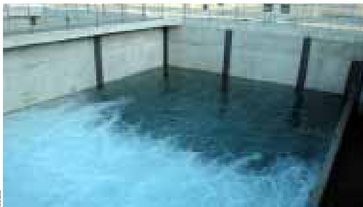
◀ Filtre de carboni de la potabilitzadora d'Abrera. Amb processos com la filtració i la decantació, l'aigua natural esdevé apta per al consum.
