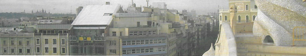
Torre de refrigeració de l'edifici La Pedrera, dos torres fusionades en una i una torre revestida per pantalles acústiques
